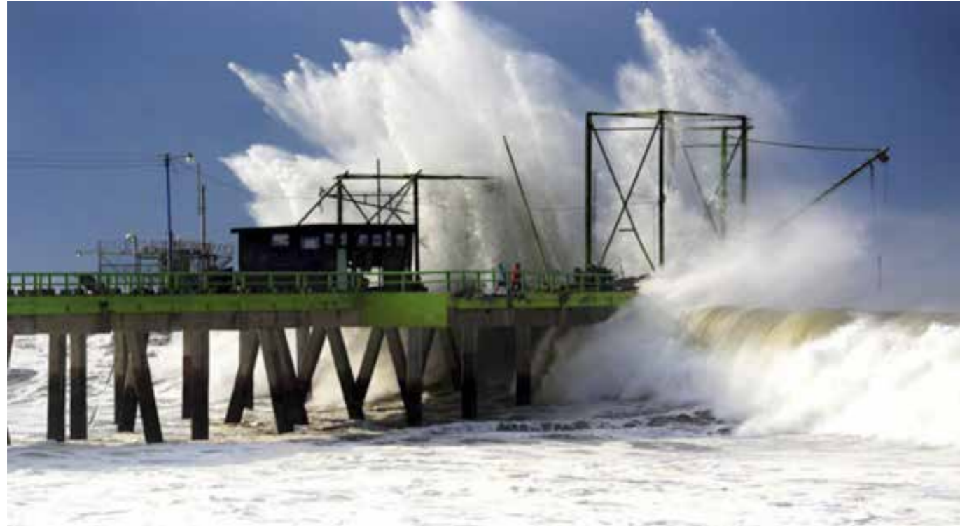
Figura 106. Fuerte oleaje impactando la estructura del muelle de La Libertad entre el 2 - 4 de mayo de 2015 (Foto: Mario Amaya) Fuente: Elaboración propia MARN
