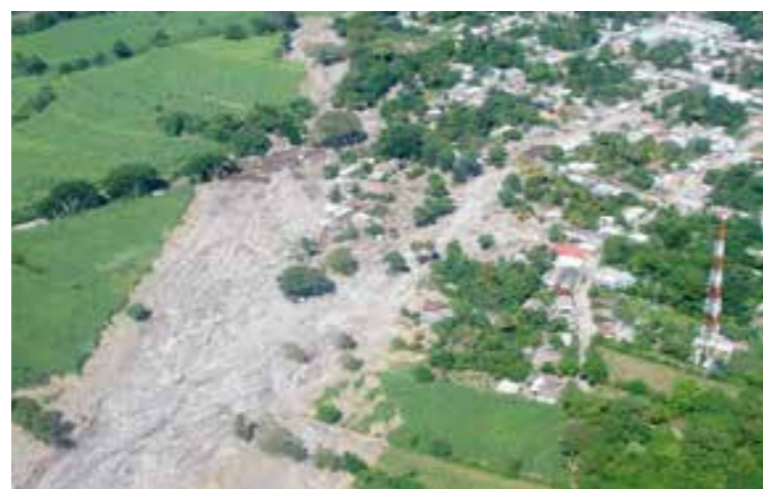
Figura 61: Flujo de escombros que afectó la ciudad de Verapaz en San Vicente, noviembre 2009 Fuente: MARN
