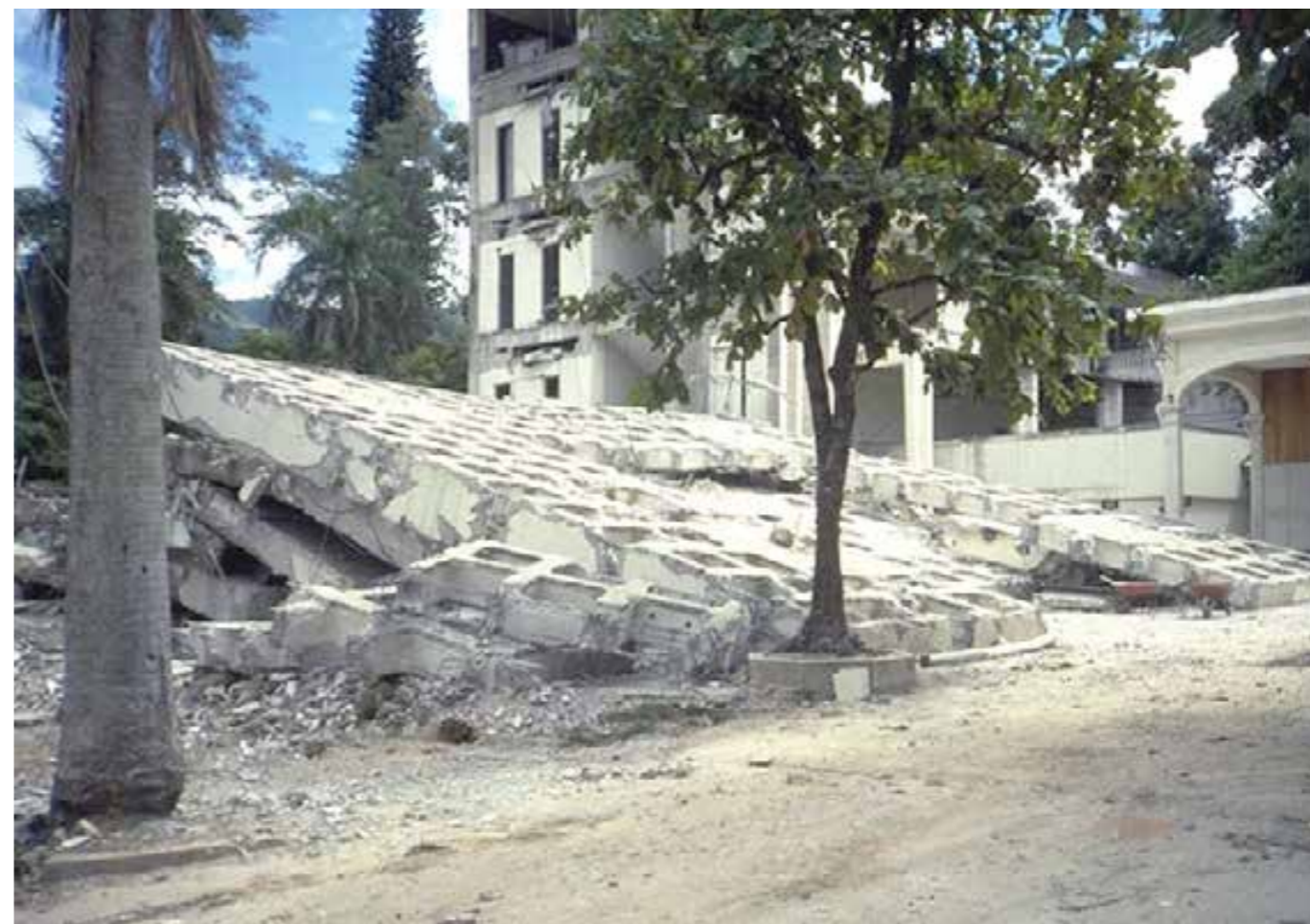
Figura 132. Daños observados durante el sismo de 1986, M5.7 – San Salvador Fuente: Earthquake Engineering Research Institute, 2001 M 7.7 & M 6.6 El Salvador Series
