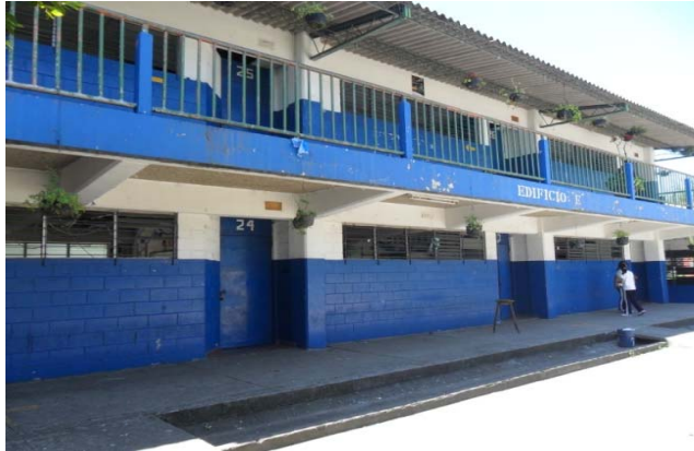
a) Fotografía de Fachada
